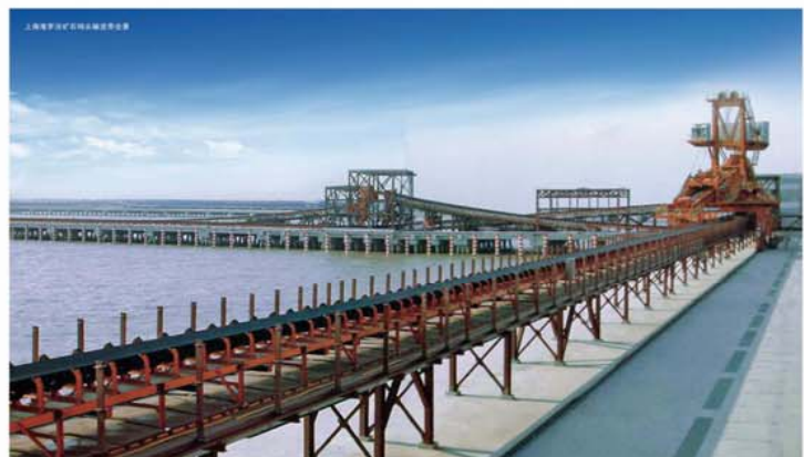
上海港罗泾矿石码头输送带使用全景
